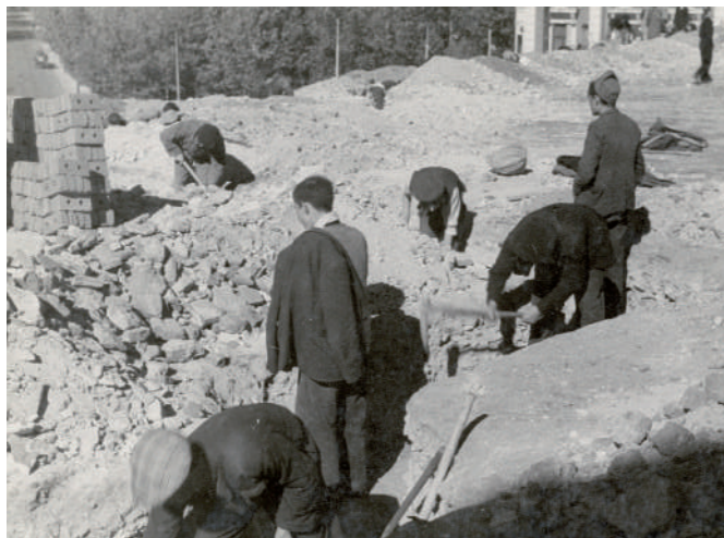
Trabajos de fortificación en Plaza de España, Madrid Fortification works in Plaza de España, Madrid
